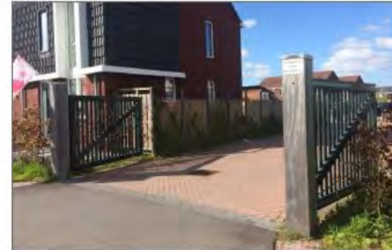
entree erf duidelijk vormgeven
